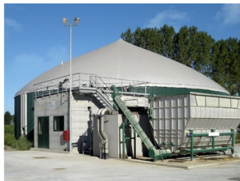
Impianto di biogas
